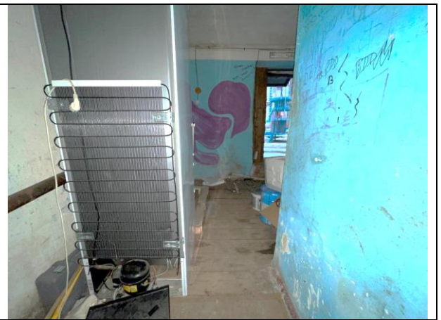
Фото 18. Типичное состояние Объекта оценки
