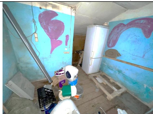
Фото 21. Типичное состояние Объекта оценки
